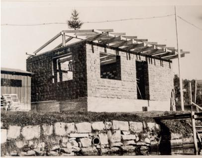
Die Wachstation steht im Rohbau und ist bereit zum Richtfest. Der Firstbaum ist bereits angebracht.
